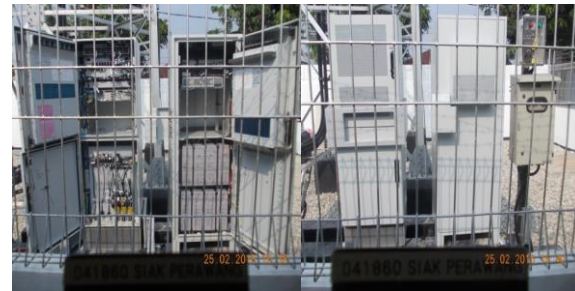
Gambar 32. Perangkat BTS Selesai Diinstallasi
