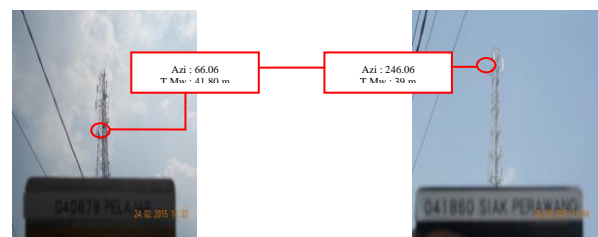
Gambar 27. Antena Microwave Dikedua BTS
