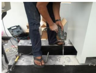
Gambar 17. Pembuatan Kedudukan untuk Rectifier dan BTS 3G
