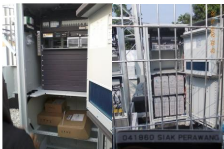
Gambar 18. Sebelum dan Sesudah Pemasangan Perangkat Rectifier
