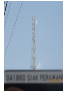
Gambar 31. Tower Beserta Antena Selesai Diinstallasi
