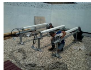
Gambar 8. Pemasangan Mounting Antena Sectoral
