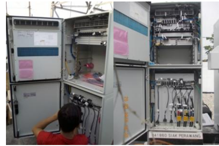
Gambar 19. Sebelum dan Sesudah Pemasangan Perangkat BTS 3G
