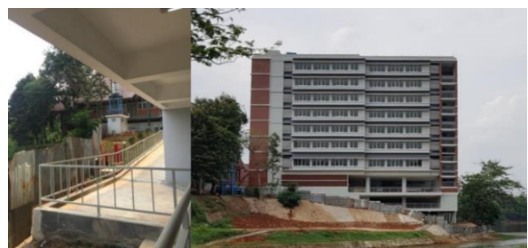
Gambar 4. Tampak sisi selatan
