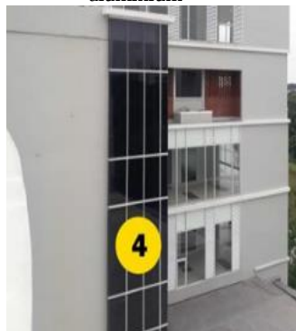
Gambar 6. Curtain wall menggunakan kaca film ( tinted glass )
