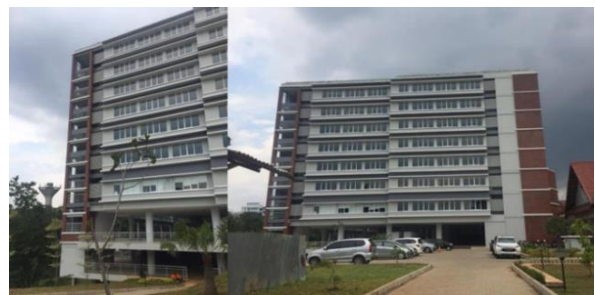
Gambar 3. Tampak sisi utara
