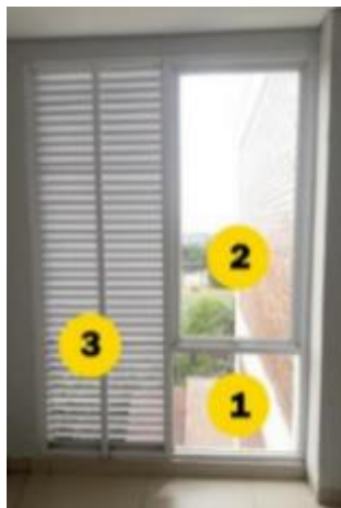
Gambar 5. fixed glass , jendela top-hung dan jalusi aluminium
