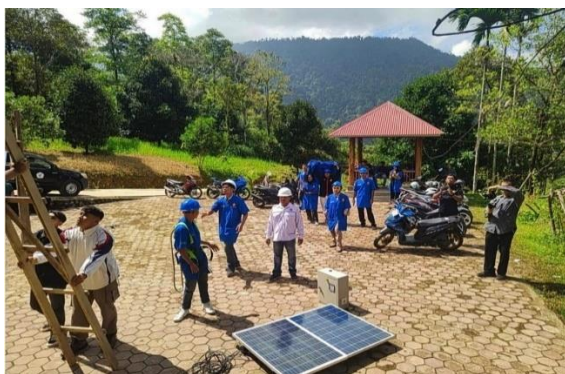
Gambar 6. Persiapan Pemasangan PLTS
