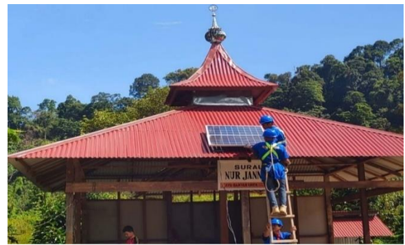
Gambar 7. Pemasangan Komponen PLTS
