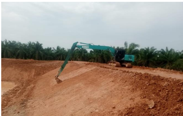
Gambar 13. Pekerjaan sloping
