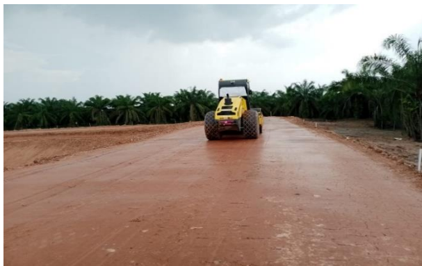
Gambar 12. Proses pemadatan dengan vibro roller
