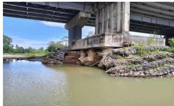
Gambar 2. Pilar Jembatan Dari Depan
