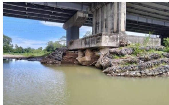
Gambar 3. Pilar Jembatan Dari Samping
