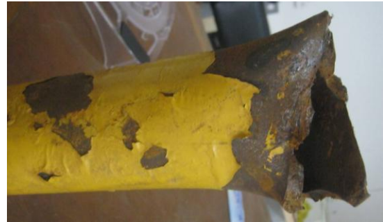
Gambar 2. material boom Crane yang akan di uji
